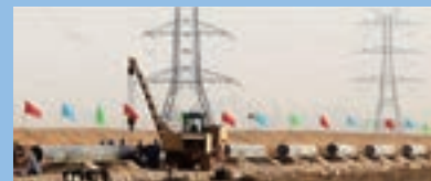
水移送用パイプライン敷設現場(総敷設距離610km)
