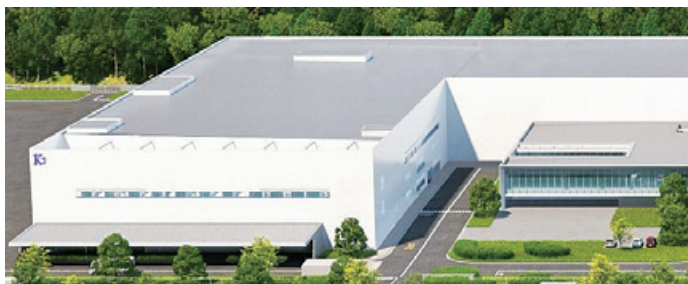
CMP装置の新生産棟を建設中(熊本事業所)
