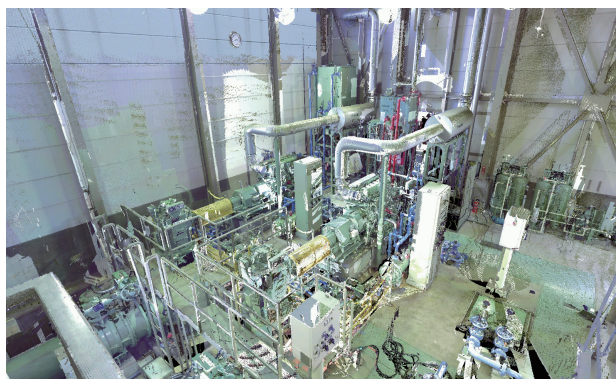
図10 更新工事前の機場内点群データ
