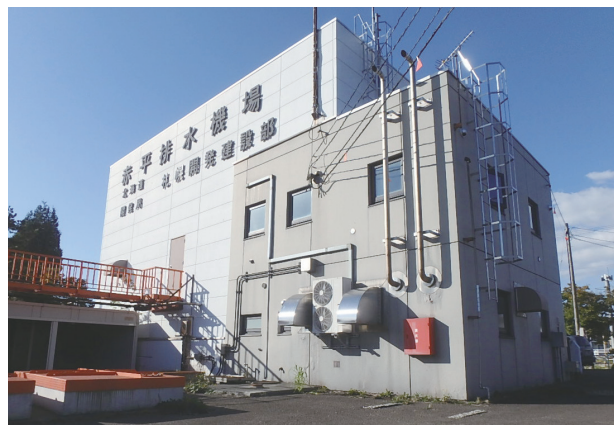
図2 機場外観写真
